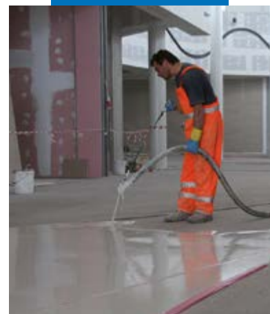
Aanbrengen van Ultratop met een pomp
