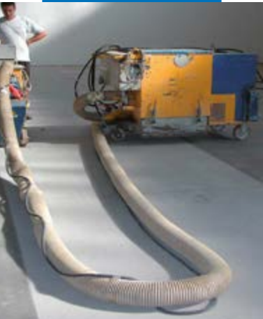
Vorbereiden van de ondergrond door gritstralen
