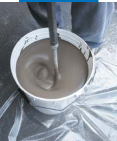
Bereiding van het product met een boormachine
