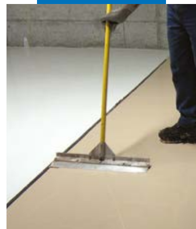
Gladstrijken van Ultratop direct na het gieten
